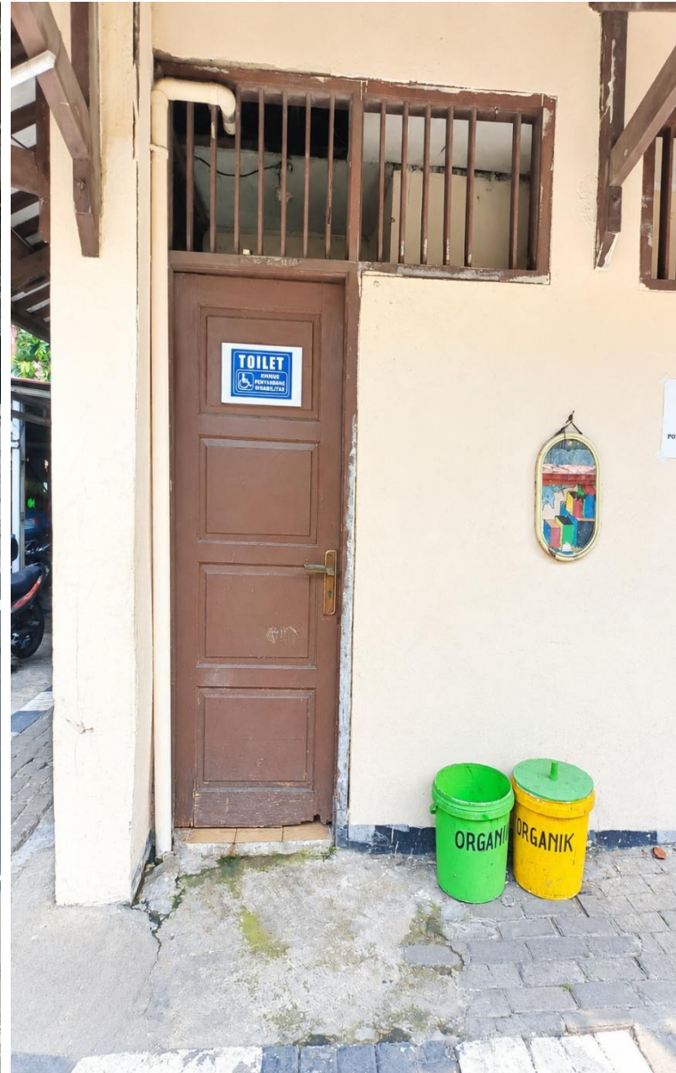
Toilet Khusus Disabilitas
